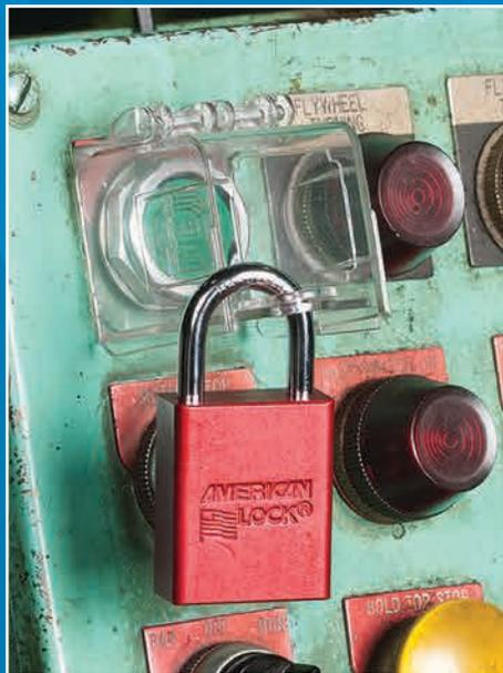
Les couvercles amovibles pour bouton-poussoir (S2151) comprennent un couvercle, une base fixe et une base repositionnable avec ruban adhésif double face. Ils sont compatibles avec les boutons de 50 mm de diamètre et 45 mm de haut.
